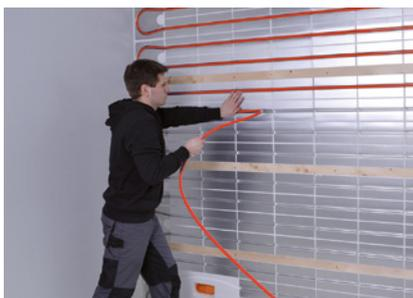
Mehrschicht-Verbundrohr in einem Bogen in die Rohrführungen der Heizelemente drücken. Maximale Heizkreislänge 80 m.
