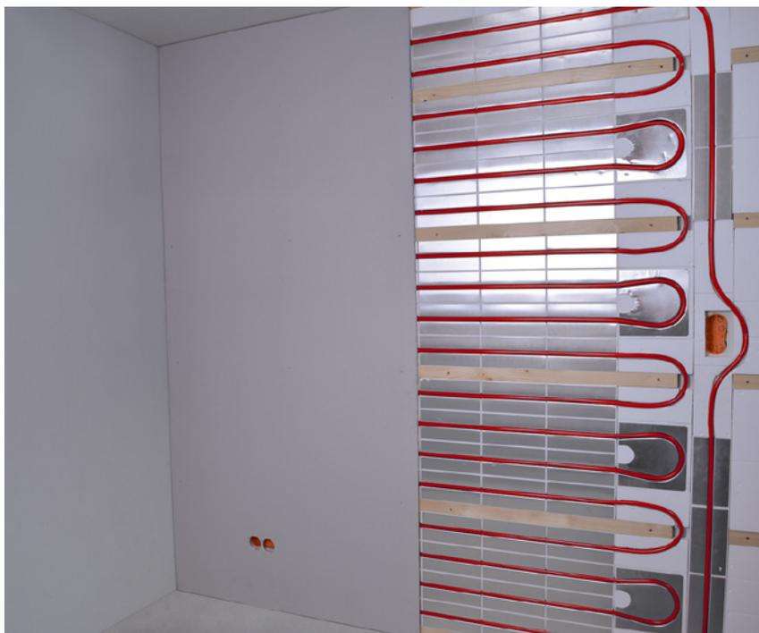
Auf dem Bild oben sehen Sie die fertig verlegte Wandfläche mit Proline ENERGY BasicLine. Die Ränder als Bewegungsfuge werden z.B. mit Acryl ausgefüllt und Übergangsfugen verspachtelt. Bei der gesamten Montage der Trockenbauplatten sind die jeweiligen Herstellerangaben zu beachten.
