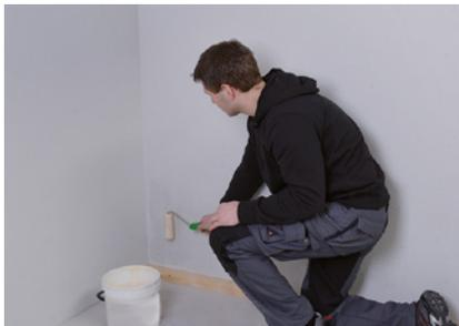
Mit Montageholz beginnen. Zum Fixieren der Systemelemente wird ein geeigneter Kleber angewandt.
