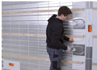
Feldwechsel, Zuleitungen und individuelle Rohrführungen werden mit Randelementen aufgefüllt. Mit dem Heißschneider individuelle Rohrführungen ausschneiden.
