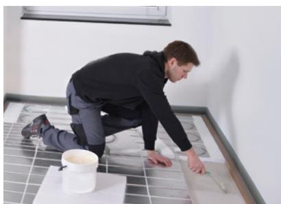
Anschlüsse an Wandflächen sowie Ausgleichsflächen werden mit BasicLine Randplatte aufgefüllt und vollflächig verklebt.
