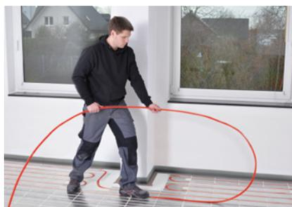
Mehrschicht-Verbundrohr in einem großen Bogen von oben spannungsfrei in die Rohrkanäle drücken. Maximale Heizkreislänge 120 m.
