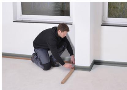
Randdämmstreifen umlaufend an der Wand verlegen. Rahmenholz anpassen und auf tragfähigen Untergrund verkleben.
