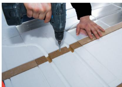
Im Türdurchgang das Rahmenholz vollflächig verkleben, ggf. mit dem Untergrund verschrauben. Übergangsschienen lassen sich so später leicht anbringen.
