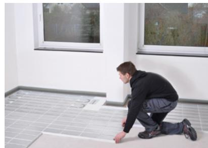
Verlegung der Rohträgerelemente wie zuvor beschrieben fortführen.
