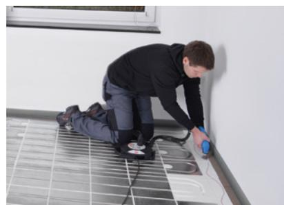
Mit dem Heißschneider individuelle Rohrführungen ausschneiden. Bei langen Rohrführungen diese in Wellenlinien ausführen.
